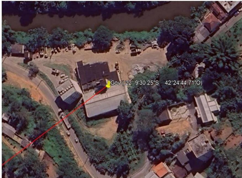
Imagem 5 - Vista Aérea do Lote
