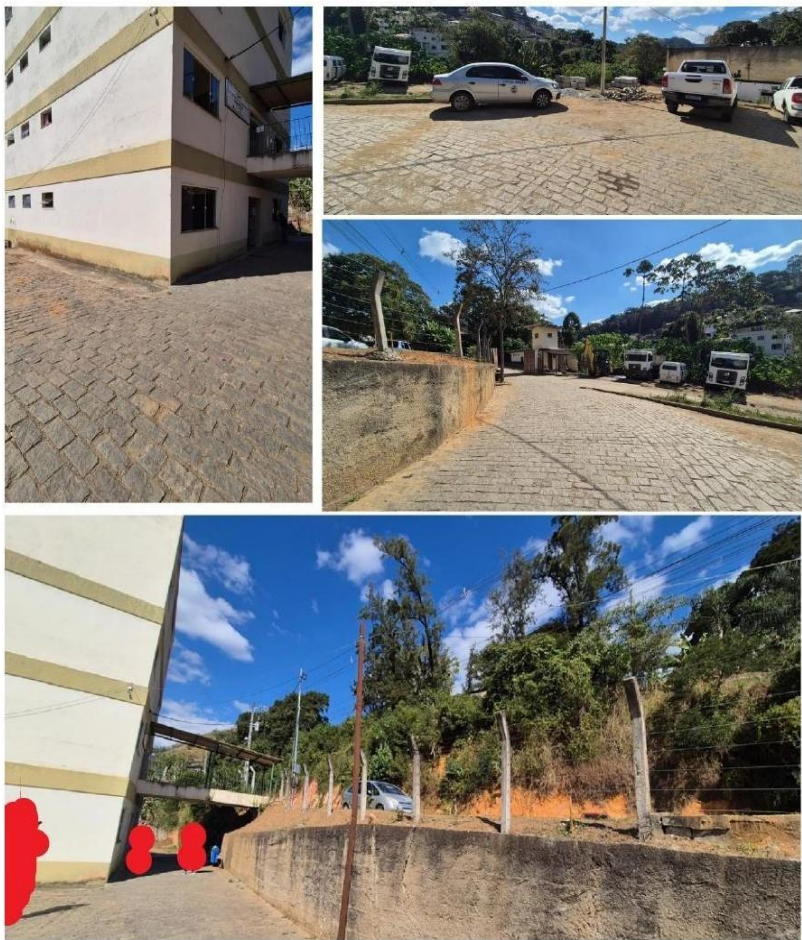
Imagem 4 - Pannel Fotográfico do Empreendimento – Fachadas, Pátio Interno e Entorno Imediato
