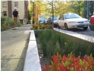
Os Jardins de Chuva são canteiros com plantas, localizados próximos ao meio fio e rebaixados, que têm como principal objetivo a captação das águas da chuva que escoam pelas ruas e calçadas, além daquelas que incidem diretamente no canteiro. O solo com capacidade de infiltração deverá absorver as águas pluviais captadas.
