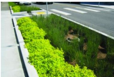
Biovaletas são depressões preenchidas com elementos, tais como vegetação e solo adequado, que têm como finalidade o tratamento das águas da chuva e o aumento do seu tempo de escoamento. Após filtrada, a água poderá ser direcionada a tratamentos complementares ou devolvida às redes de drenagem locais.
